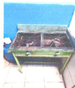
Foto 4: REPARACIÓN O SUSTITUCIÓN DE ÁREA DE COCINA sustitución de estufa industrial existente
