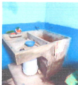
Foto 3: REPARACIÓN O SUSTITUCIÓN DE ÁREA DE COCINA sustitución pila, nivelada y con conexiones hidráulicas.
